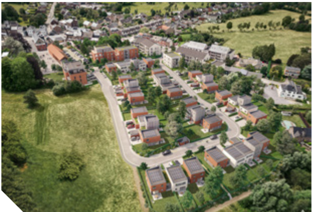
▲ HJO Real Estate Thimister - Quartier de la Cidrerie, Thimister PROJECTTYPE Herwaarding van een industriële brownfield tot een wijk ARCHITECT HGA - BAG
