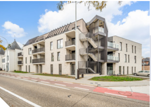
▲ Group GL International Louah, Zoutleeuw PROJECTTYPE Residentieel ARCHITECT Everaerts Architecten
